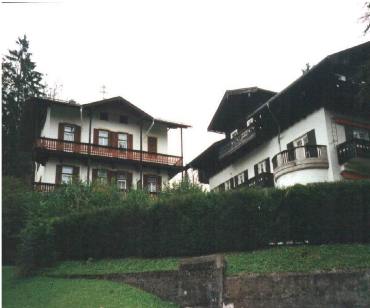
Südansicht der Villa Askania, Photo Verfasser, 1999.
