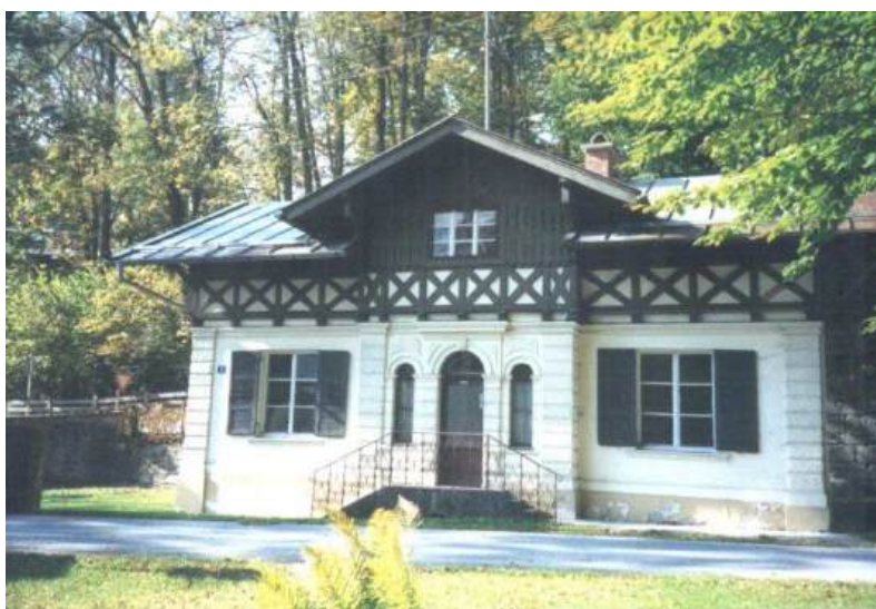
Foto Verfasser 2000, ehemaliges Pförtnerhaus der Villa Bayer in der östlichen Grundstückshälfte.
