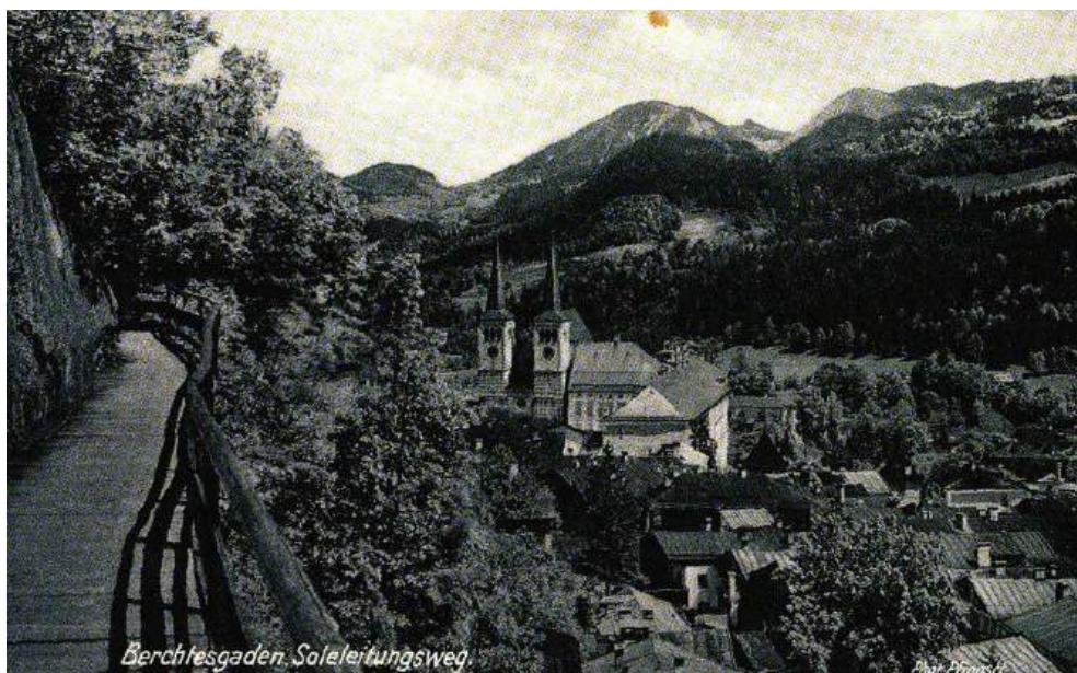
Blick vom Soleleitungsteg nach Nordosten über die Dachlandschaft des Marktes auf Schloß und Stiftskirche, um 1930, E.-M. Ilsanker, 1995, S. 28.
