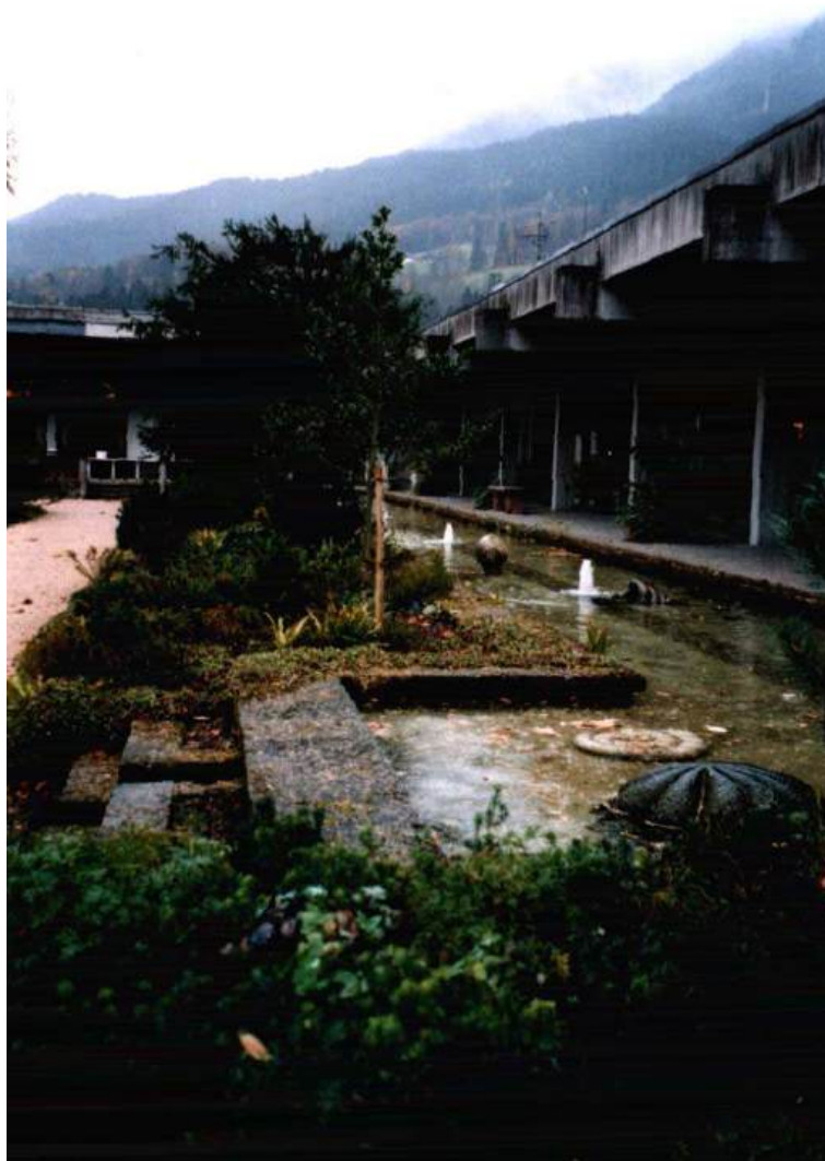
Ausschnitt Hofgarten, Alpinum-Anlage mit Wasserbecken am südlichen Ende des Kurgartens, vermooste und beschädigte Trittstufen im Vordergrund, Photo Verfasser, 1999.
