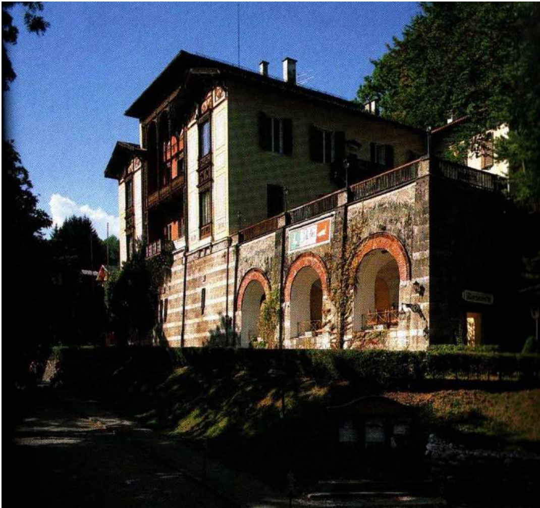
Vorderansicht Königliche Villa von Südwesten, Kälbersteinstraße, Photo Verfasser, 1999.
